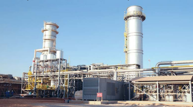
Oxy Mukhaizna HRSG Erection Project
